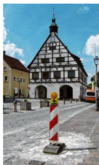
Am Marktplatz wurden Leitungen für „Live am Marktplatz“ und den Wochenmarkt unter Boden verlegt. Foto: Imm
